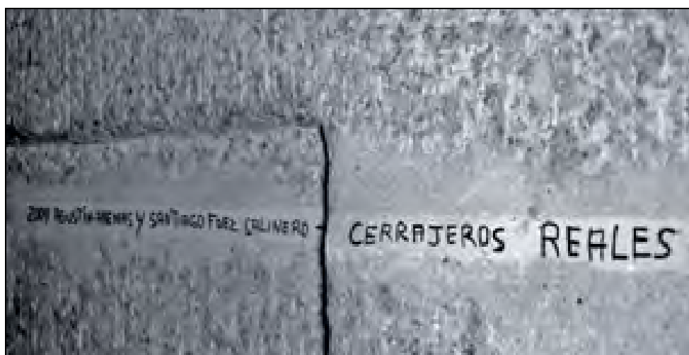
26) Testimonio de dos obreros en los últimos trabajos de restauración.
