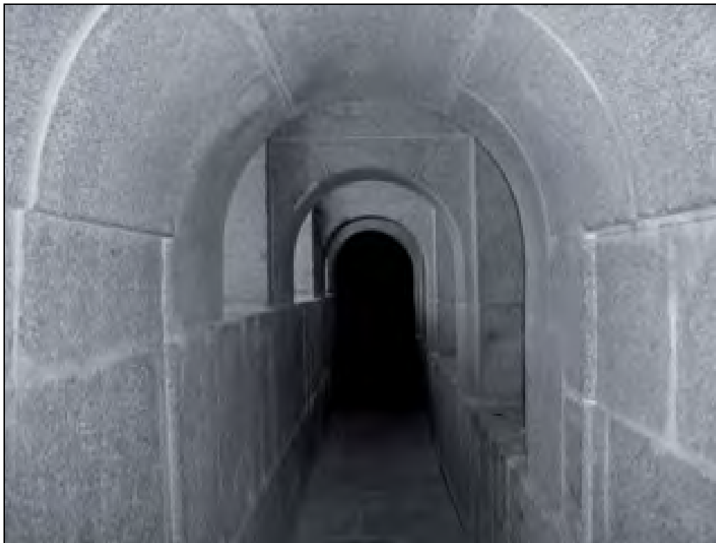
2) Galería superior que circunda toda la Basílica, situada entre la cornisa del templo y los ventanales externos.
