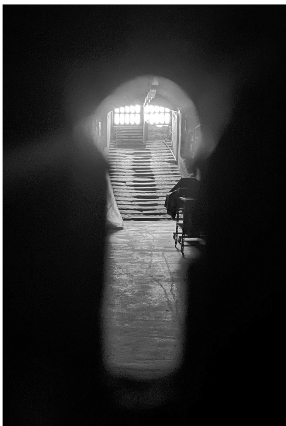
Figura 15: Fotografía de la rampa con escalones entrepicados. Realizada por la autora.
