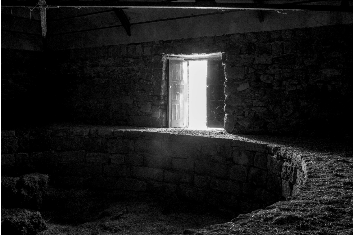
Figura 6. Interior del Real Nevero del Monasterio de El Escorial. Acceso sur. Se puede observar la parte superior del pozo descubierta un tramo de 1,5 m.
